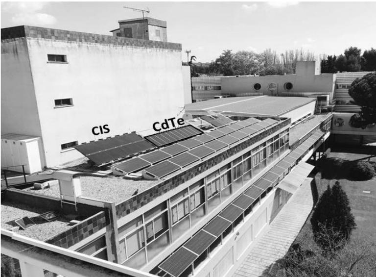
Figura 1. Generadores fotovoltaicos de capa delgada CIS y CdTe, en la terraza del IES-UPM.
