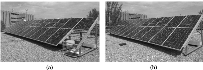
Fig. 1. Generadores fotovoltaicos de 5 kWp conectados a la red en las instalaciones del IES-Vallecas. (a) Generador 1 con 24 módulos interconectados y (b) Generador 2 con 21 módulos interconectados. Las dimensiones de ambos generadores son de 11 m x 3,3 m.
