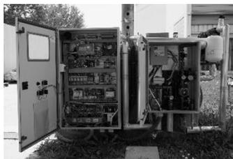
Fig. 3. Sistema eléctrico e hidráulico del disco.
