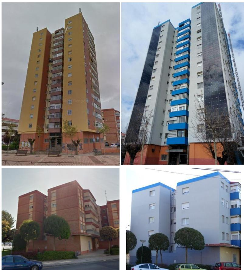
Figura 2. Aislamiento de fachadas y cubiertas (antes y después de la intervención)
