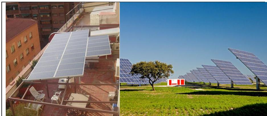
Figura 2. Generador fotovoltaico de 2,7 kW (a la izquierda) y vista parcial de una central de 48 MW (a la derecha) conviviendo en el mercado actual.
